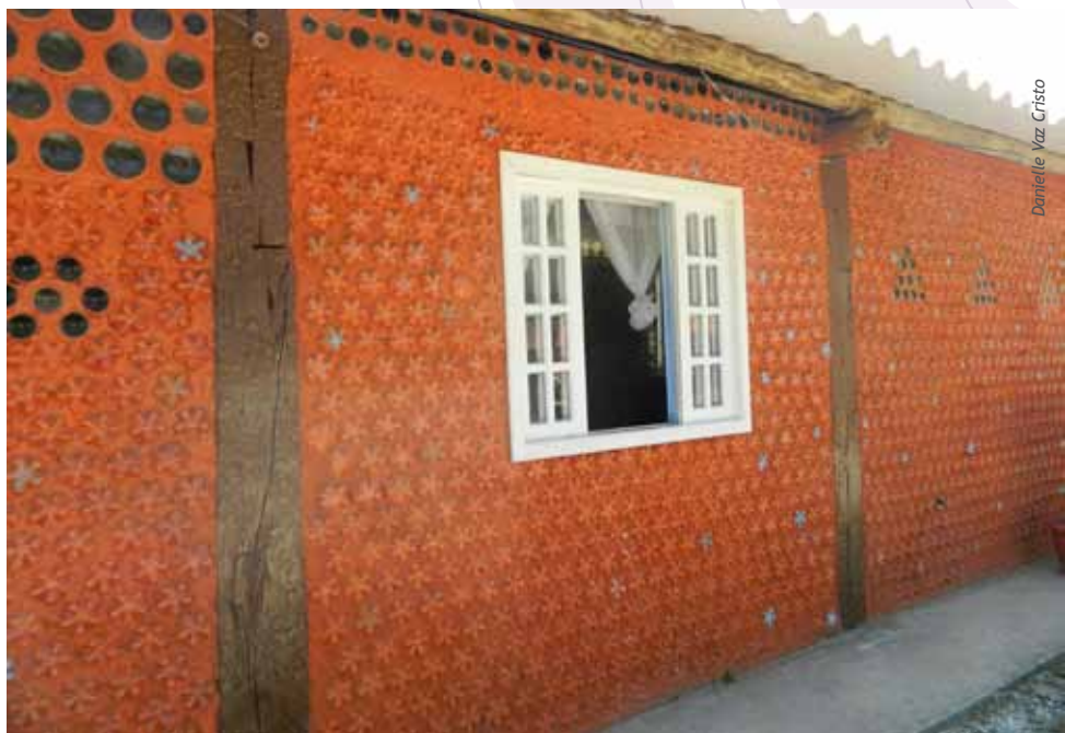
Oficina de reciclagem: garrafas PET e de vidro incorporadas à construção de paredes
