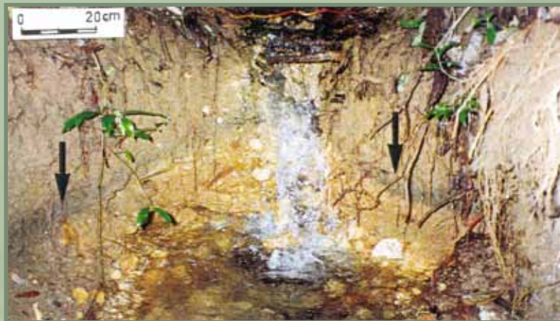
FIGURA 6 - Ruptura de declive no canal RJ2. As setas indicam um nível com concentração de carvão (paleosuperfície). Sobre ele, neste ponto, a camada de sedimento chega a um metro de espessura. O canal fluvial foi regenerado naturalmente após o reflorestamento, que teve início em 1865
