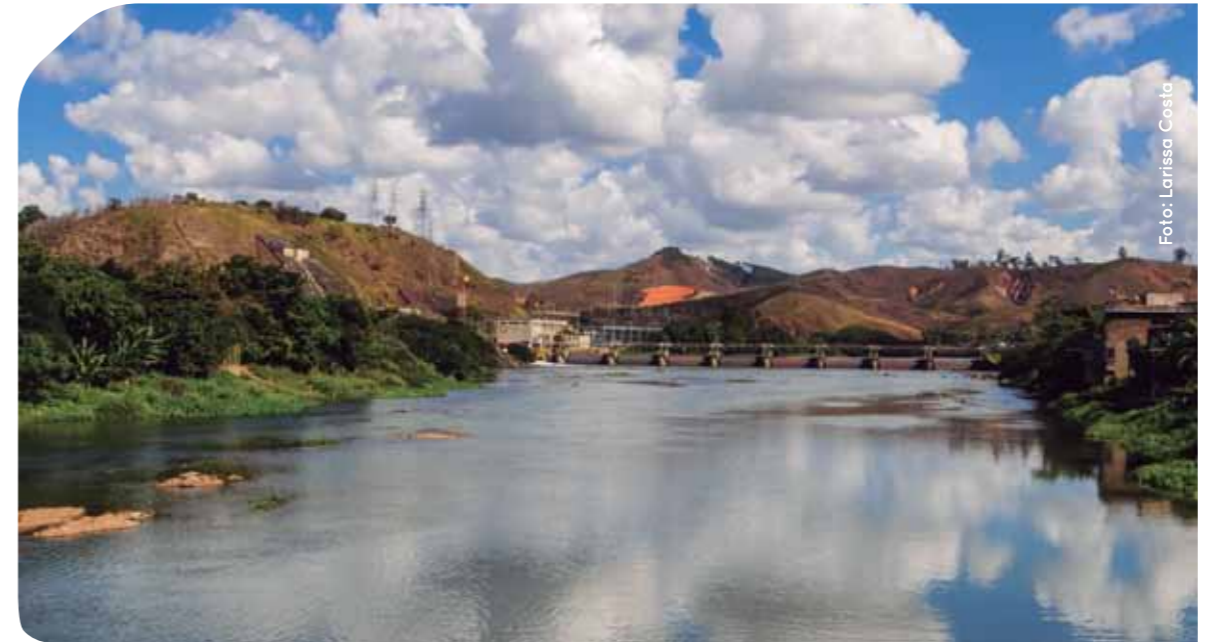
Barragem de Santa Cecília, onde ocorre a transposição de parte das águas do Rio Paraíba do Sul para o Rio Guandu por meio da estação elevatória da Light
