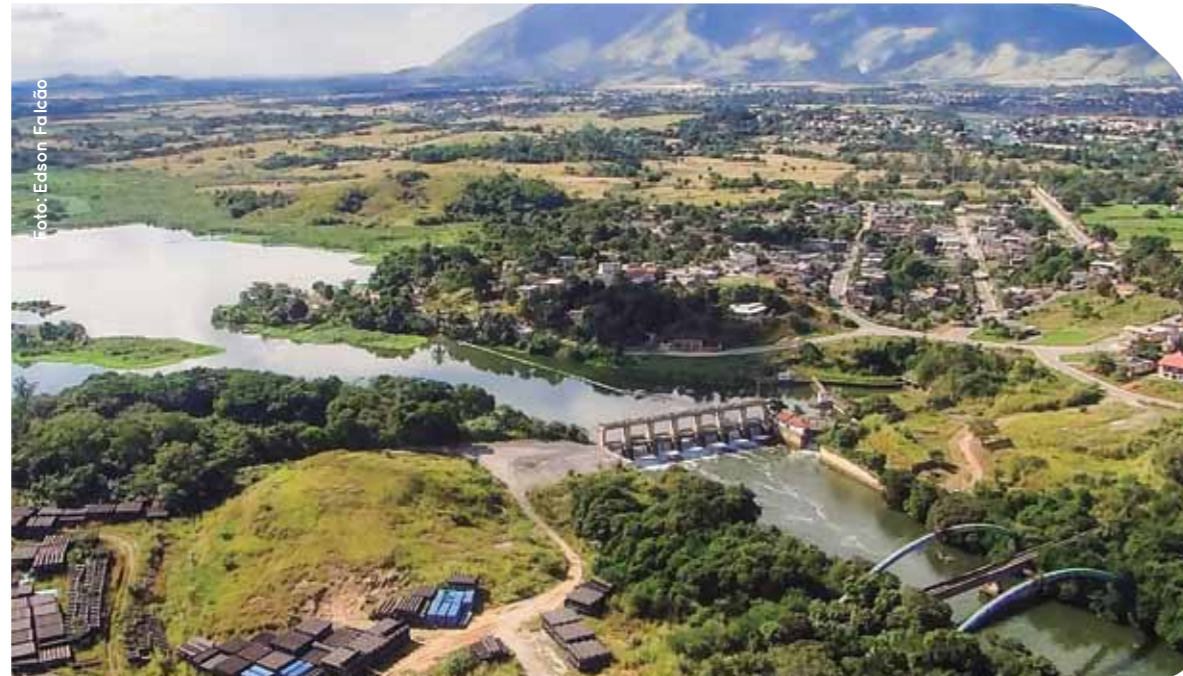
Ponto de captação da Estação de Tratamento do Guandu: depois de tratada, água é destinada ao abastecimento de vários municípios da Região Metropolitana do Rio
