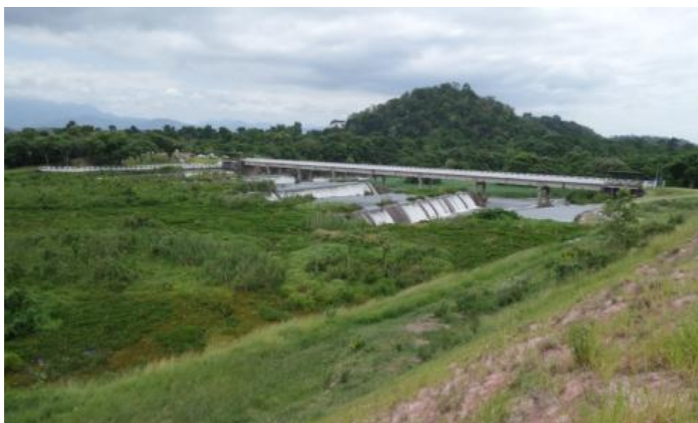
Estrutura de vertimento da barragem de Juturnaiba em Araruama.
