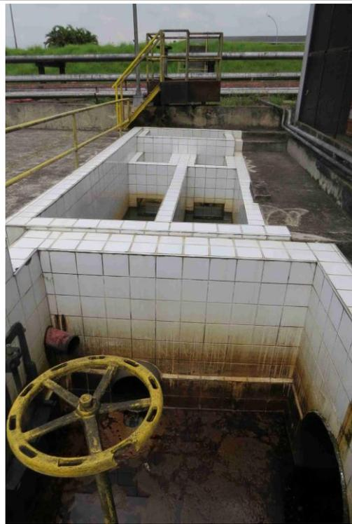
Figura 20: Vista de uma das caixas separadoras de água/óleo - CSAO
