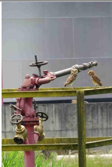
Figura 25: Canhão de água para combate a incêndio
