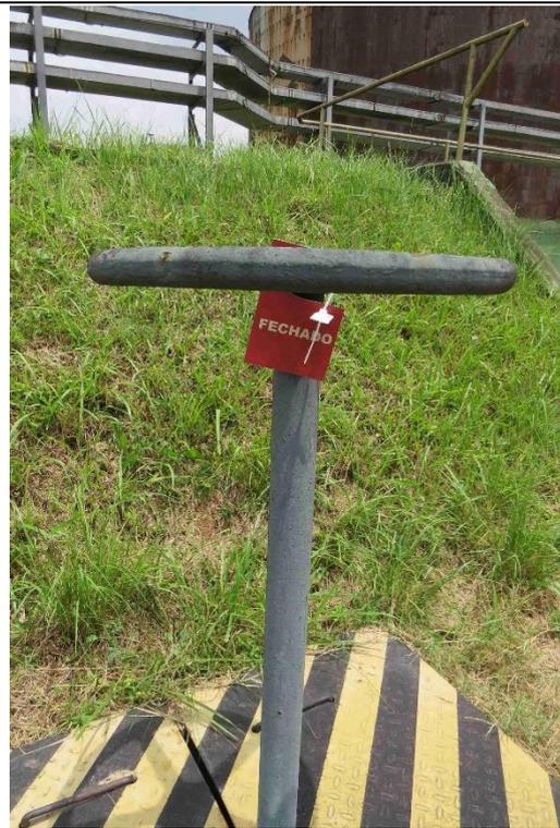
Figura 4: Válvula da drenagem dos tanques - fechada
