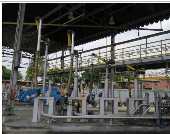
Figura 10: Plataforma de carregamento PLECT
