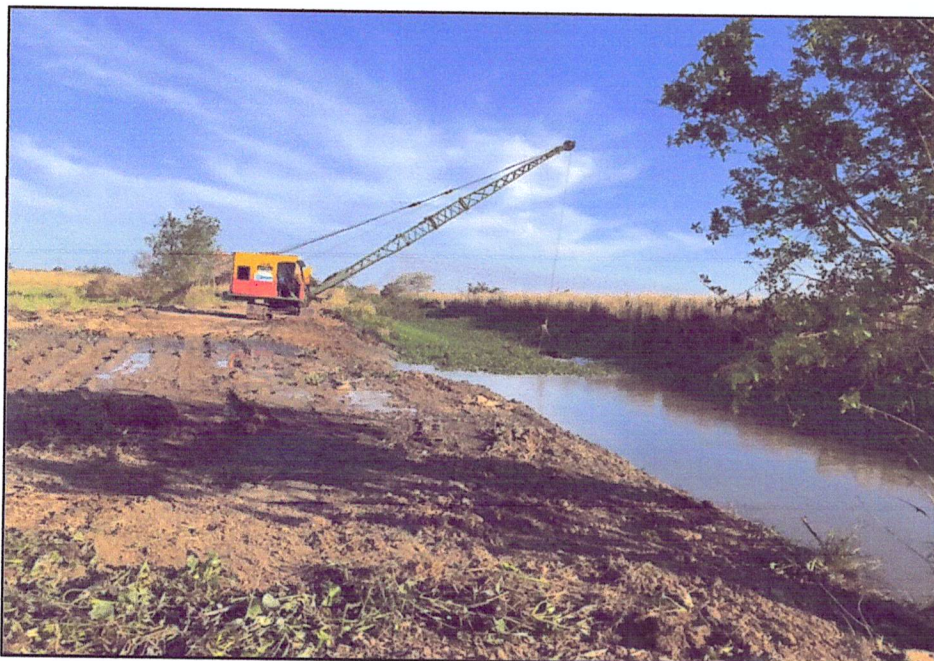
Localização 02 (Rio Cacomanga) - Trecho executado com 22 B - Será necessário de caminho de serviço para acesso de caminhões
