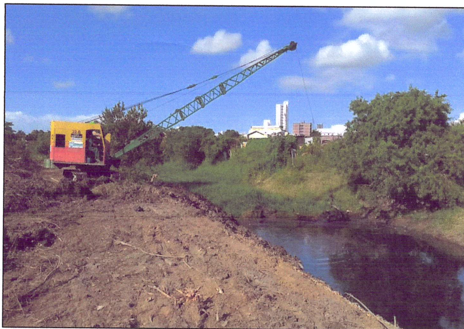
Localização 02 (Canal Coqueiro) - Serviço executado por 22 B - Caminho de serviço para entrada de caminhão?
