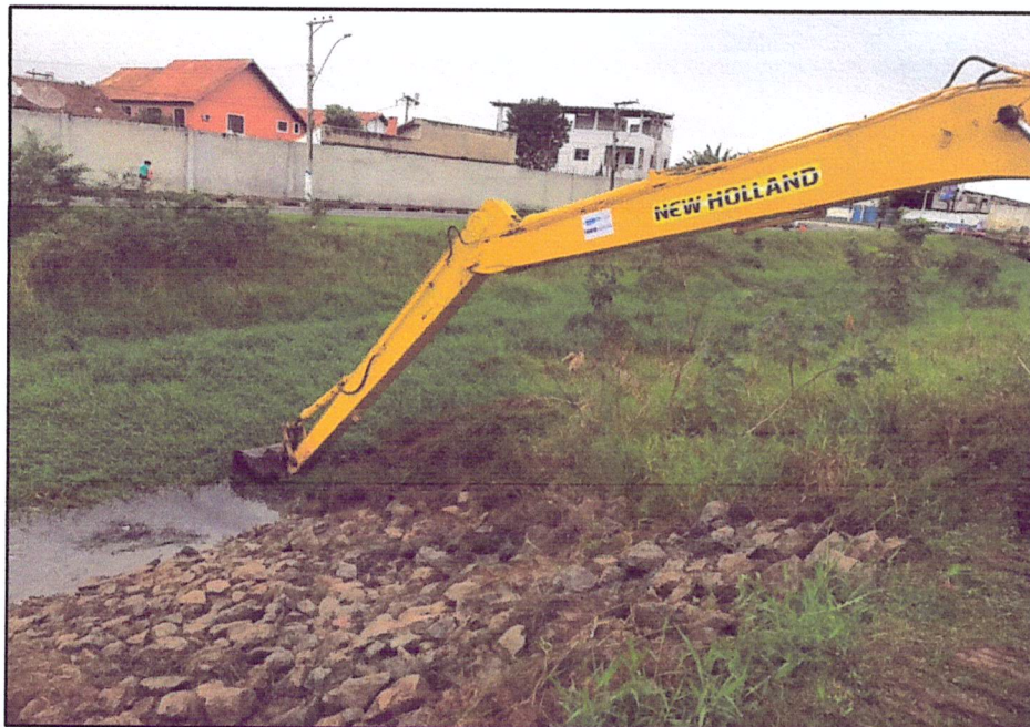
Localização 01 (Canal Coqueiro) - Trecho executado com Long - Escavadeira não alcança as duas margens apenas por um lado
