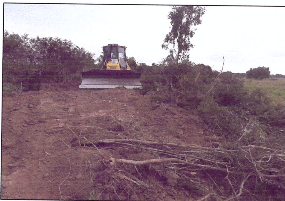
Localização 02 (Rio Cacomanga) - Serviço executado no local anteriormente necessitou de trator de esteira para execução de caminho de serviço
