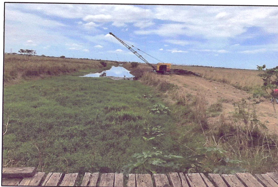
Localização 01 (Rio Cacomanga) - Trecho executado com 22 B e trator de esteira. Será necessário realizar caminho de acesso de para transporte do resíduo.
