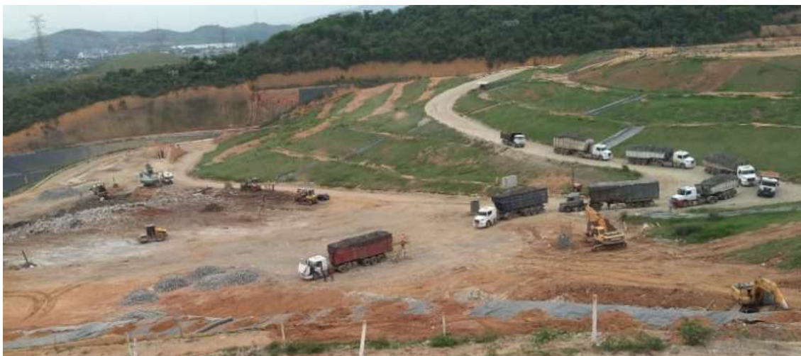
Foto 3 - Operação de chegada de resíduos no vale 04.
