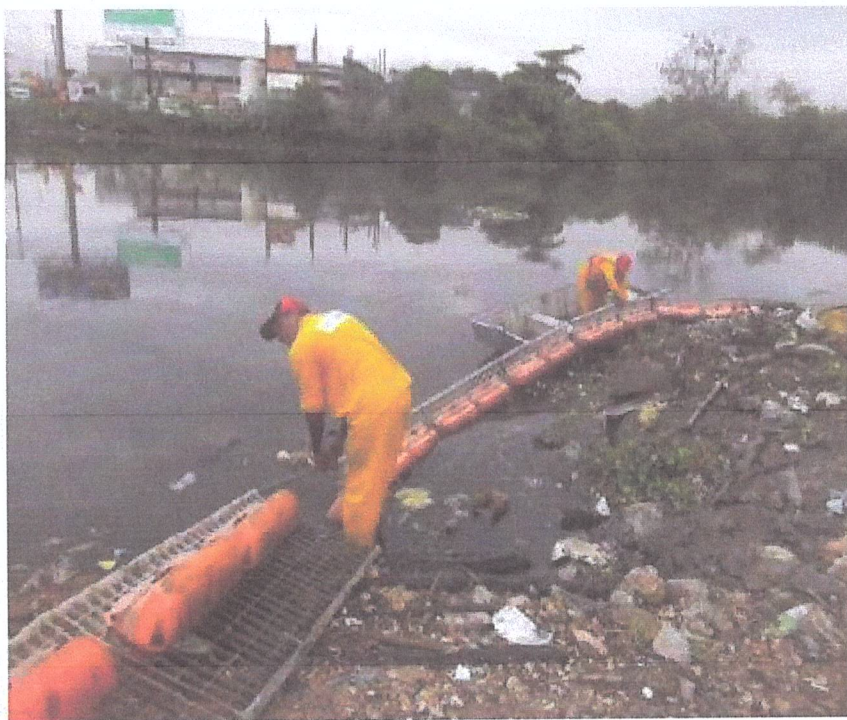
Figura 8: Exemplo de manutenção das ecobarreiras
