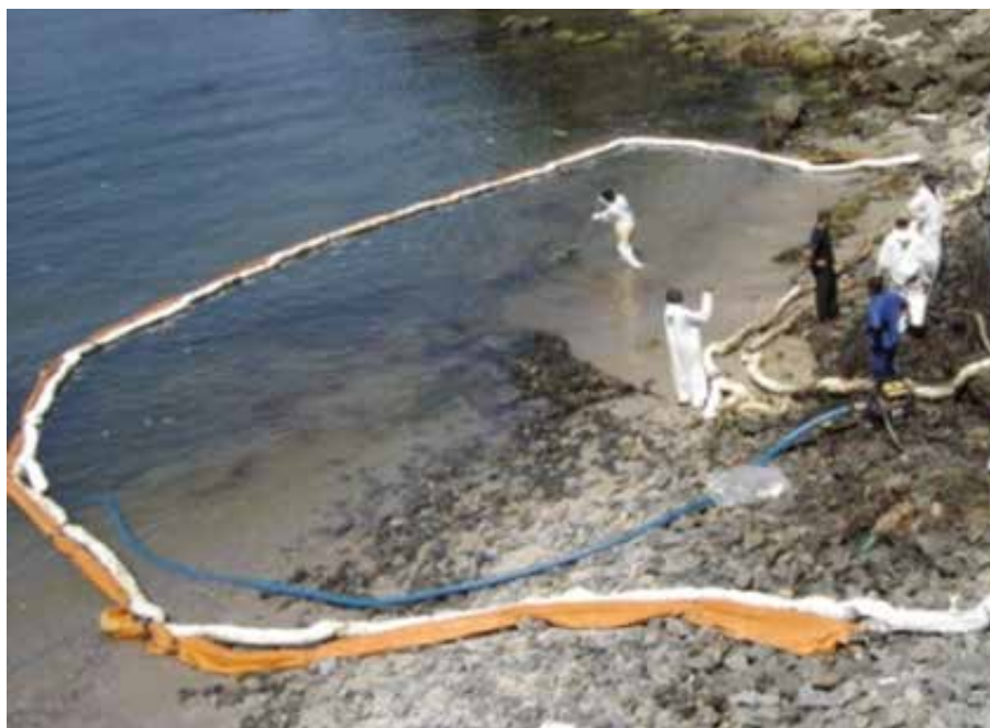
Figura 39: Operação de jateamento perto do Museu de Arte Contemporânea de Niterói Fonte: Geopem
