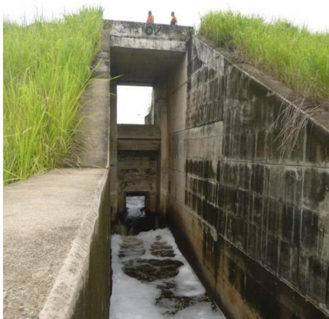
**Figura 4 – Vertedouro do rio Pavuna – vista para jusante**
