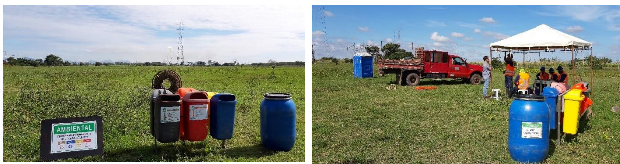
Figura 10.1. Exemplos de sistemas de coleta seletiva e de banheiro químico realizado pelo empreendedor na frente de obra.
