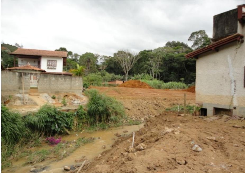
**Figura 22: Teresópolis – Etapa Emergencial – Rio Príncipe antes da execução de serviços de proteção de talude e conformação de calha.**
