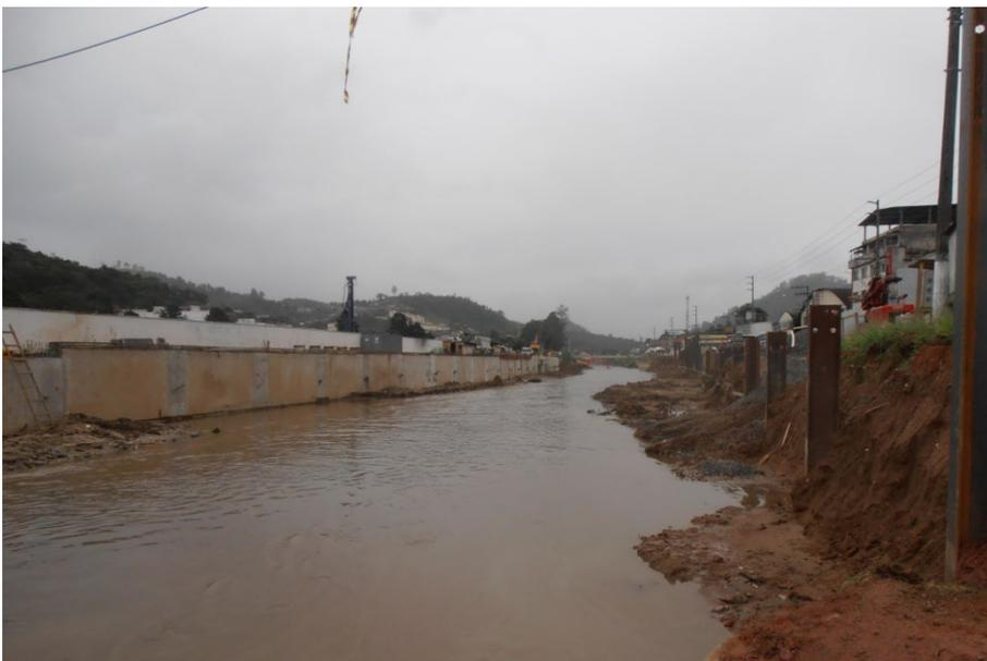
**Figura 21: Friburgo: Em Andamento – Trecho do Rio Bengalas com execução da cortina atirantada em andamento**
