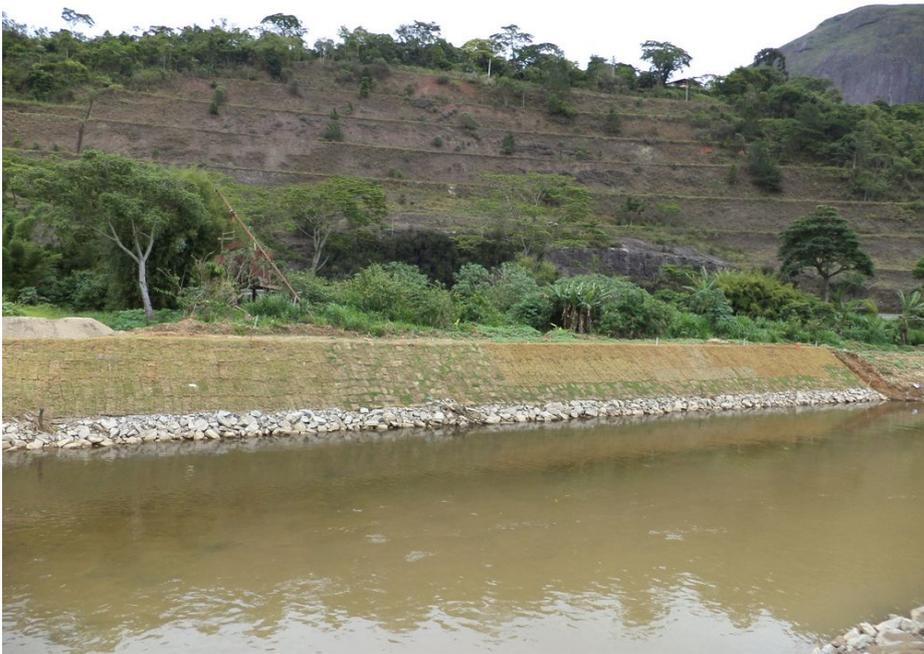
**Figura 29: Rio Piabanha após da execução dos serviços de proteção de talude e conformação de calha**
