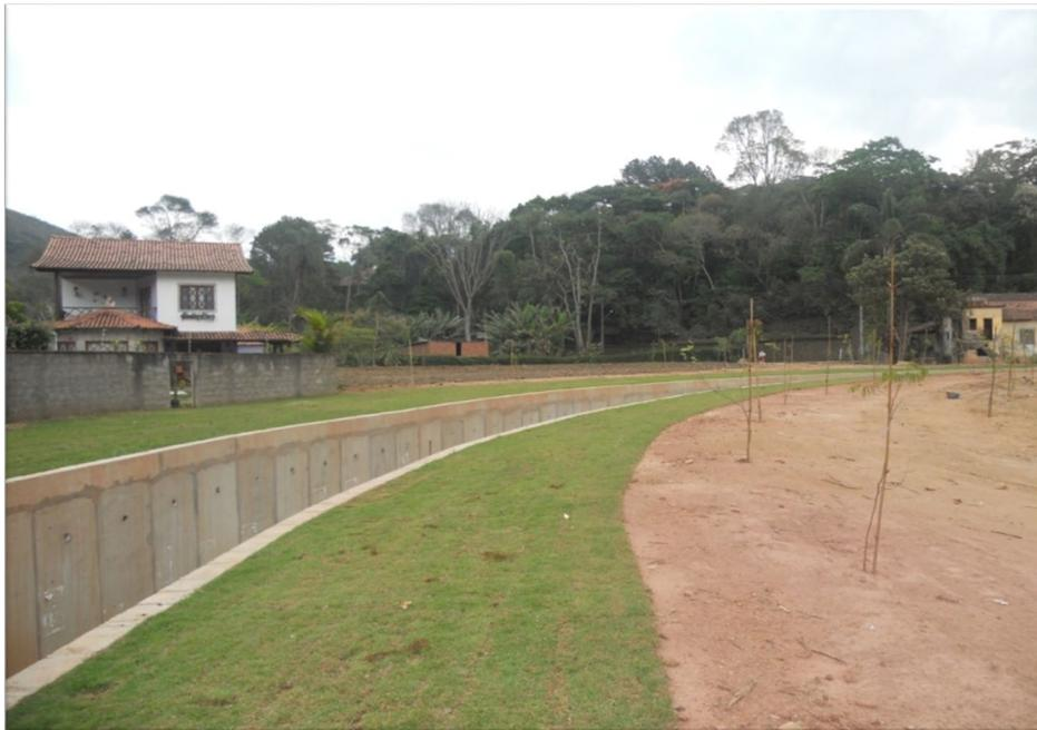
**Figura 23 : Rio Príncipe após execução de serviços de proteção de talude e conformação de calha**
