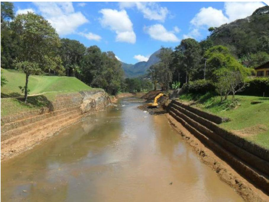
**Figura 27: Desassoreamento e limpeza das margens no rio Paquequer**
