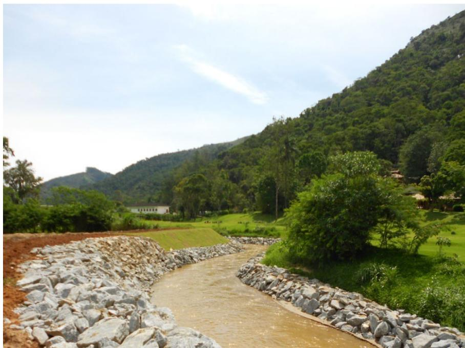
**Figura 30: Rio Cuiabá após execução do enrocamento e implantação da grama armada**
