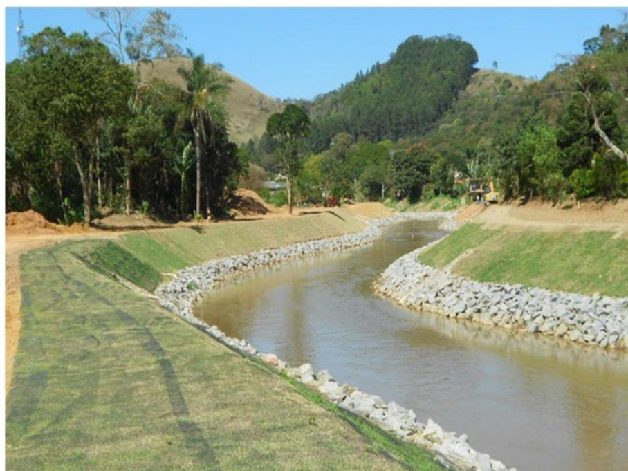
**Figura 31: Rio Santo Antônio após execução do enrocamento e implantação da grama armada**
