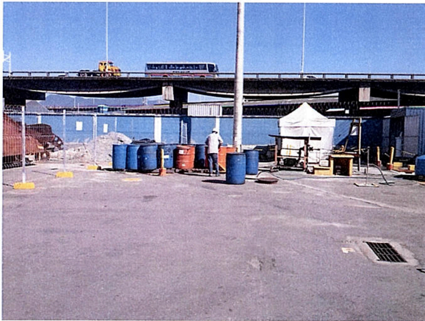
Foto 05: Vista da área de interesse.
