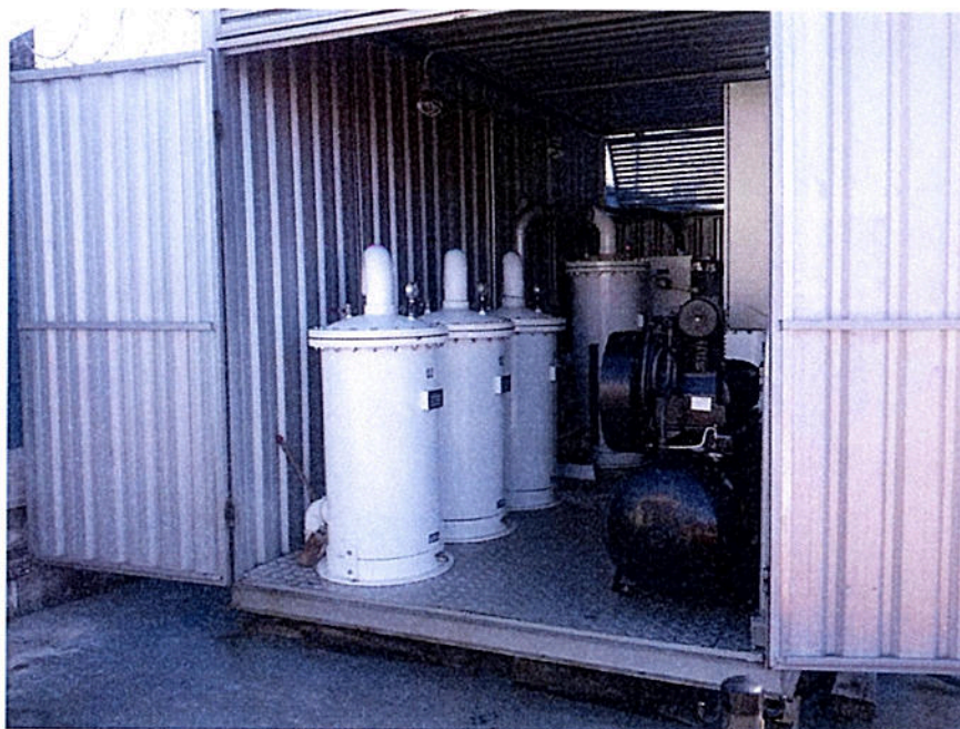
Foto 03: Vista da área de interesse.
