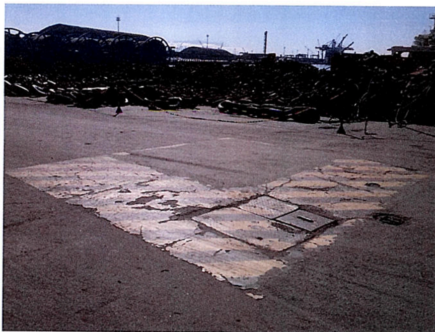
Foto 01: Vista da área de interesse.
