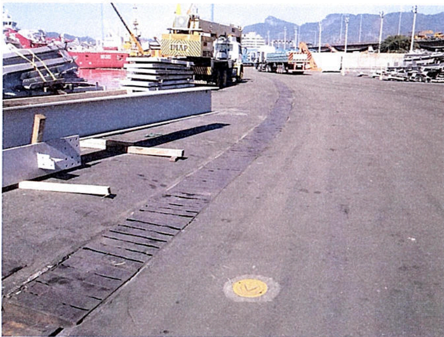
Foto 08: Vista da área de interesse.
