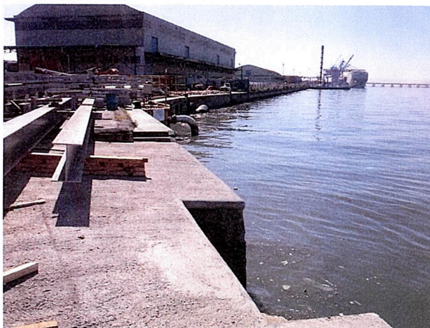
Foto 10: Vista da área de interesse.
