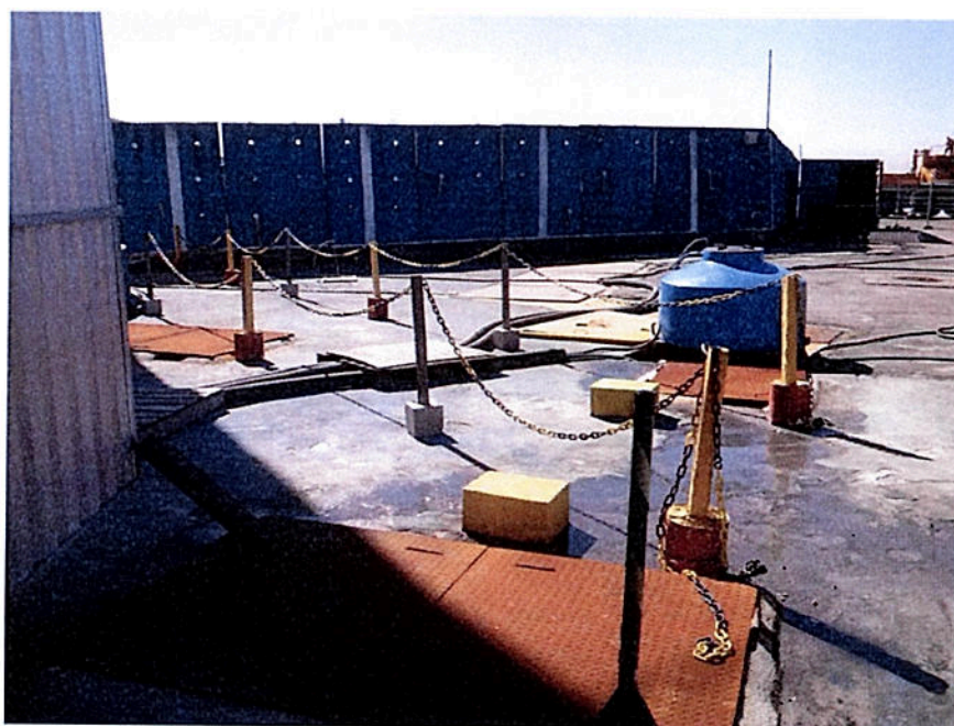
Foto 02: Vista da área de interesse.
