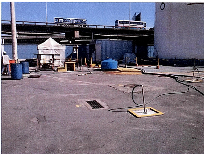
Foto 06: Vista da área de interesse.
