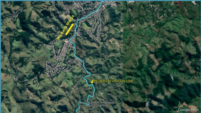
Reservatório in line no Rio Barra Mansa
