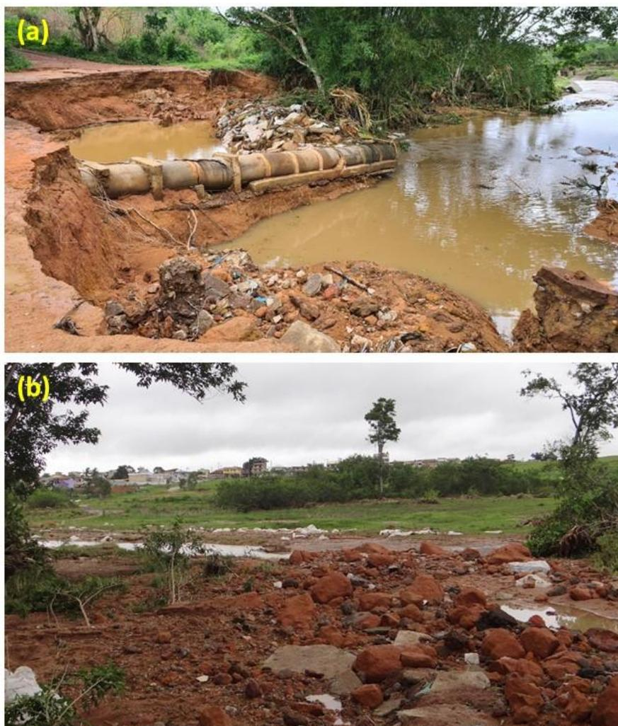
**Figura 23 – Região a jusante escavada em consequência ao galgamento da barragem, com tubulação subterrânea aparente (a) e pedras, terra e sacos de areia colocados para contenção das erosões espalhados (b)**
