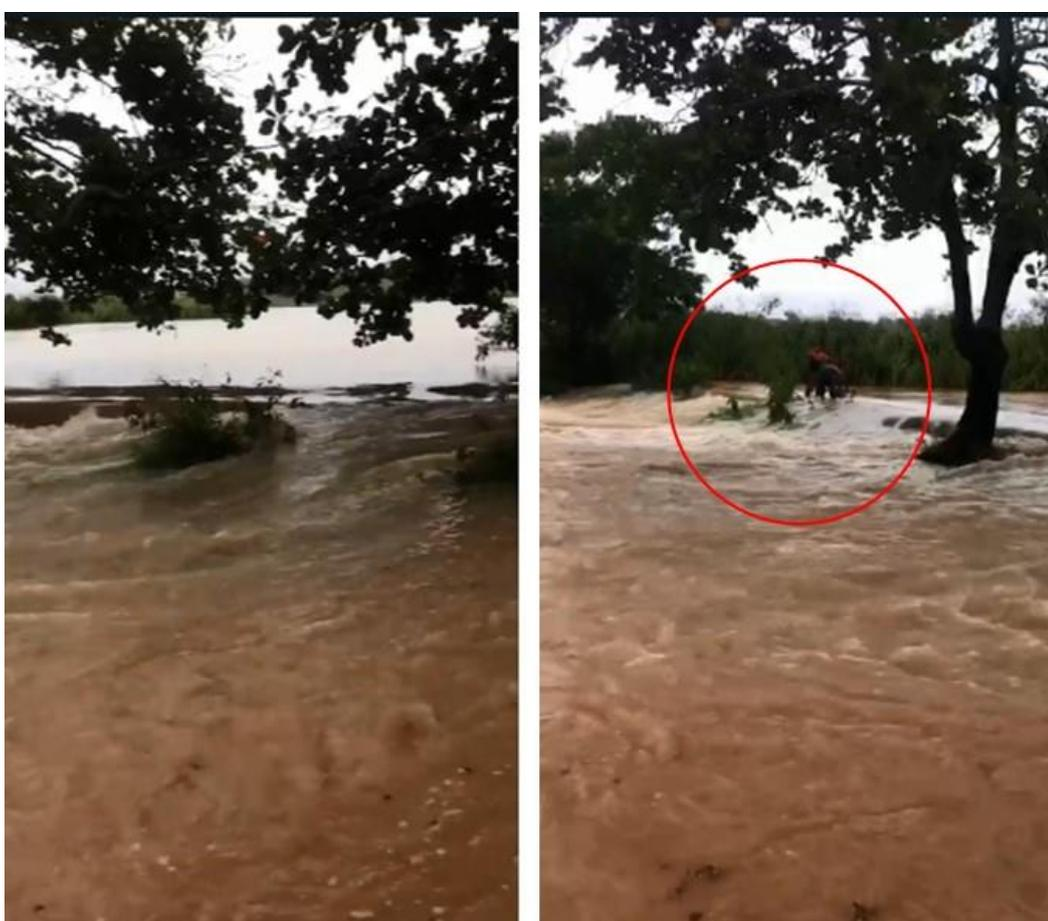
**Figura 22 – Galgamento da barragem da Maricota no dia 30/11/2022, com detalhe, à direita, para as manobras de abertura da comporta realizadas pela Defesa Civil Municipal**
