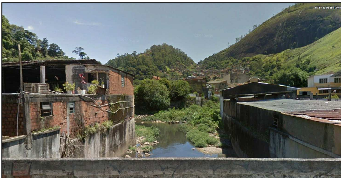
Figura 7-15 - Local de Desague do Túnel Extravasor no Rio Itamarati
