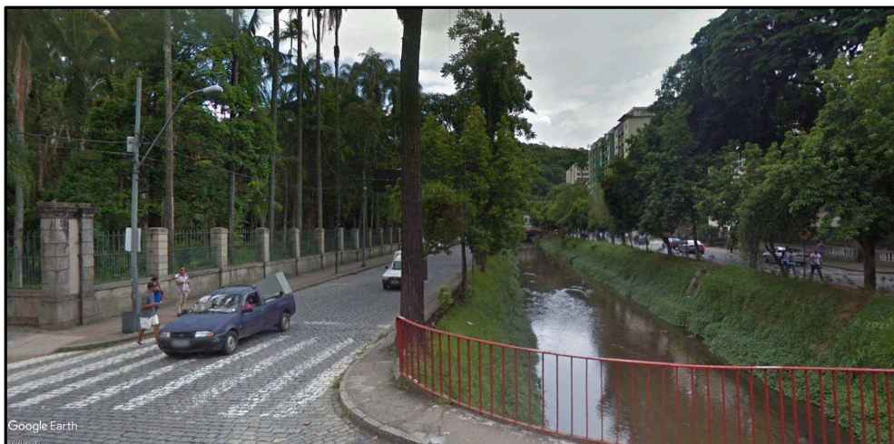
Figura 7-9 - Trecho do Canal do Centro na Rua da Imperatriz
