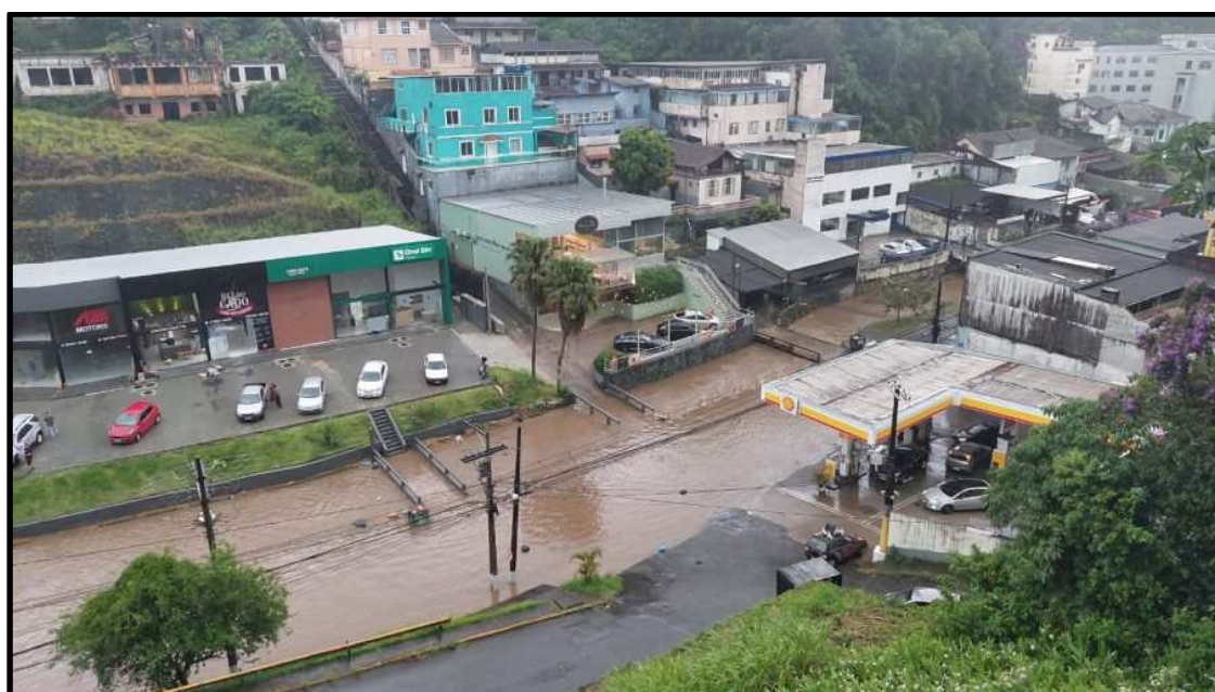
Figura 9-6 - Alagamento na Rua Coronel Veiga em Novembro de 2016
