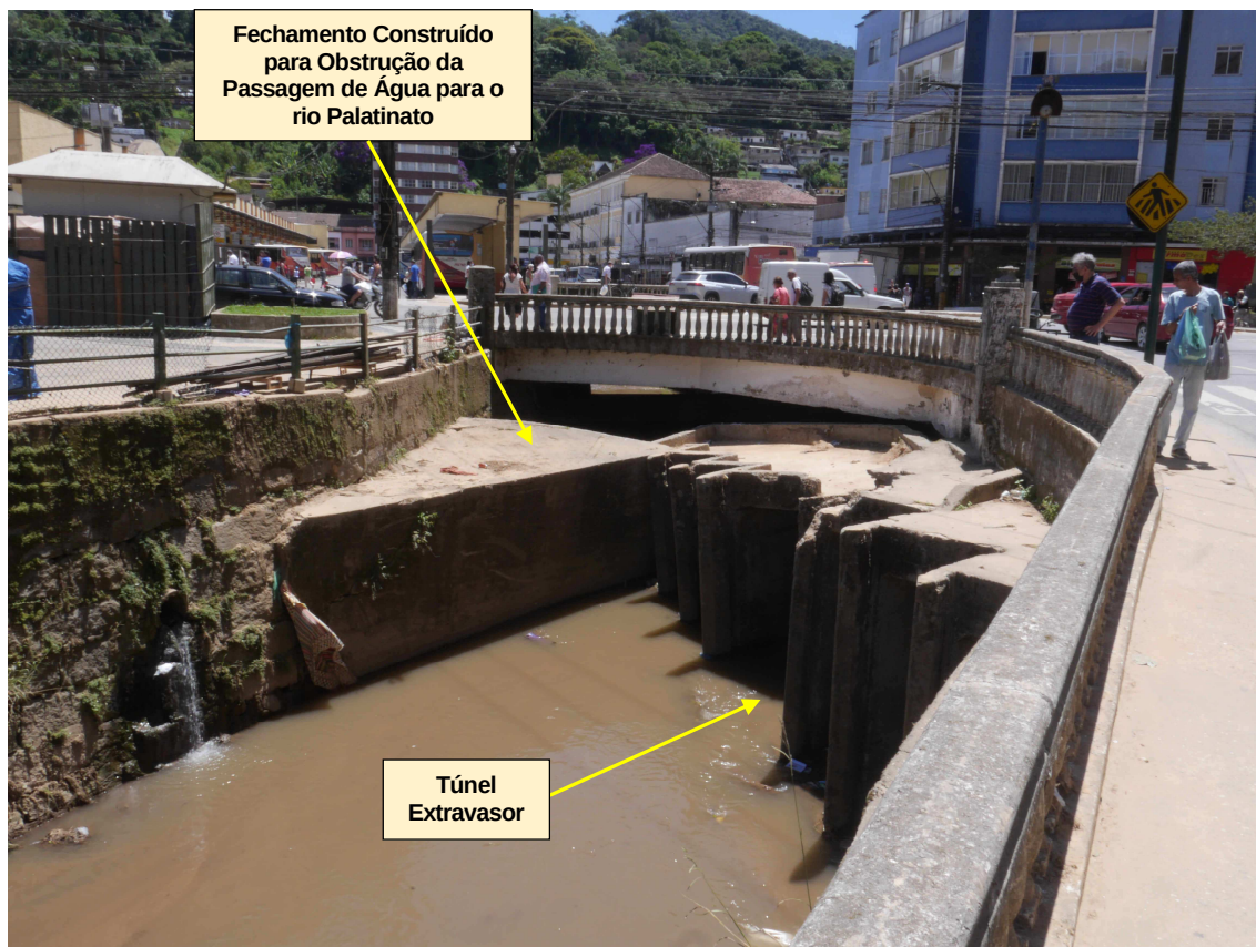
Figura 9-15 - Tomada D'Água do Túnel Extravasor em abril de 2022
