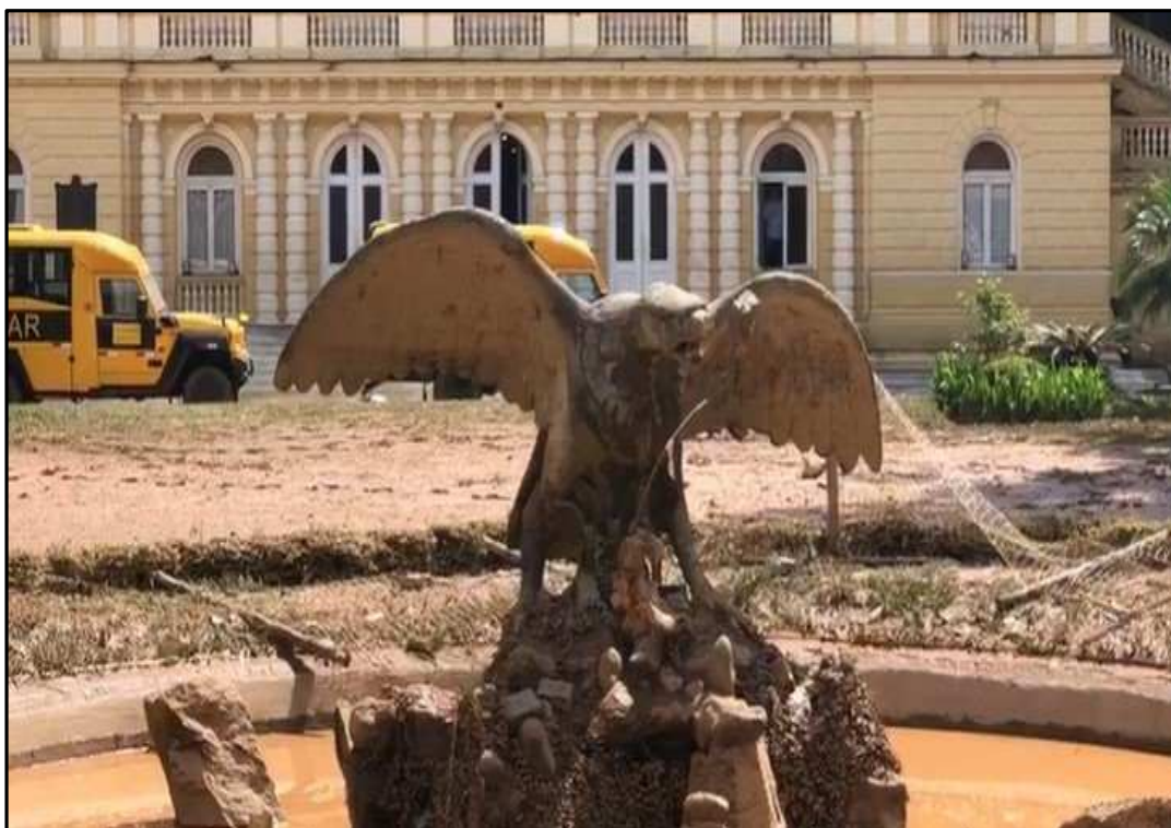
Figura 9-21 - Situação da Praça Visconde de Mauá após a Enchente. Palácio Amarelo ao Fundo
