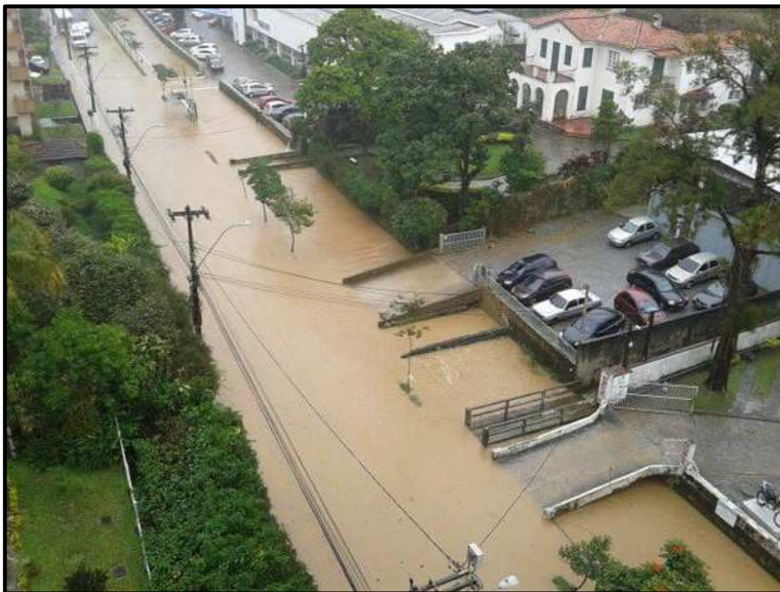
Figura 9-10 - Alagamento na Rua Coronel Veiga em 2011 (Fonte: Ana Paula Valente)
