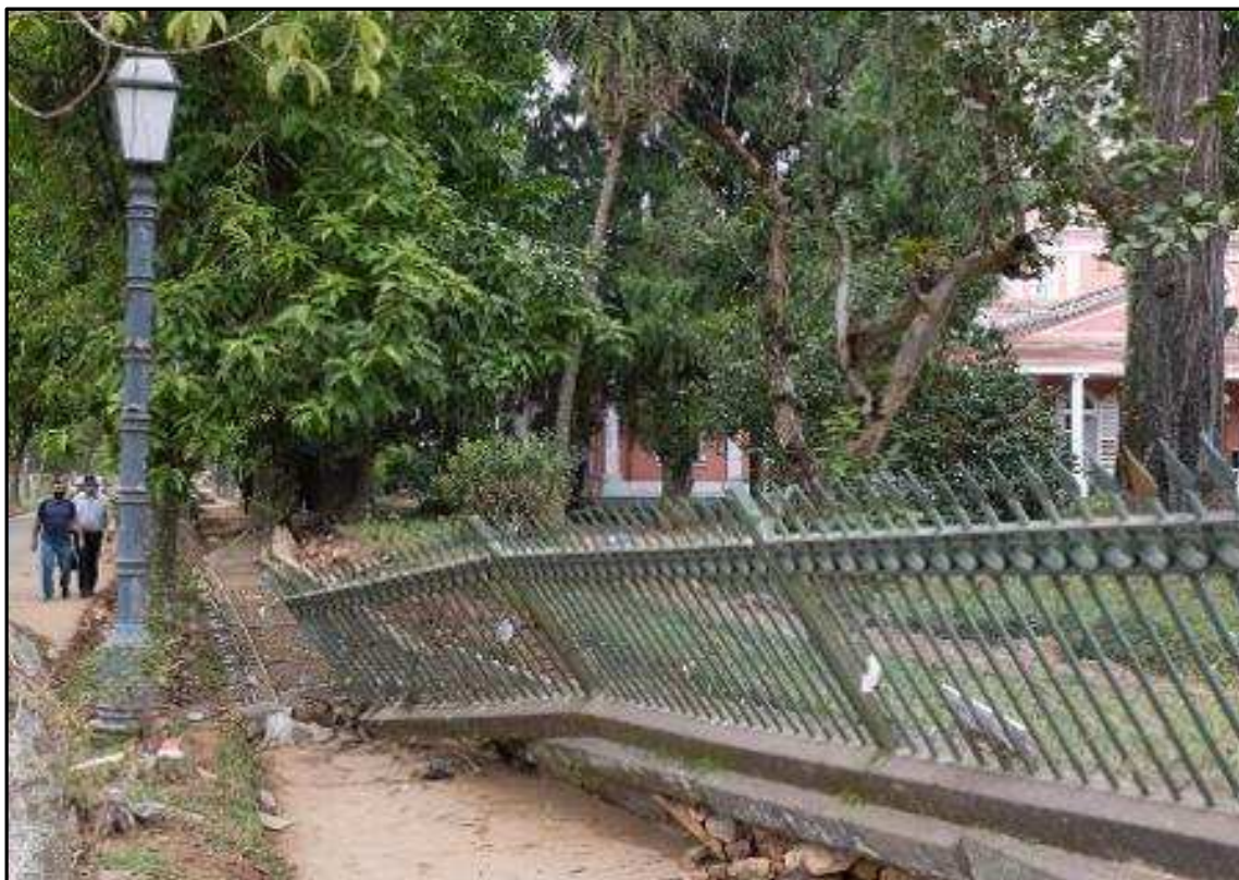
Figura 9-18 - Vista do Muro Tombado com a Casa da Princesa Isabel ao Fundo
