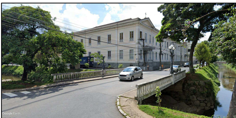
Figura 7-10 - Trecho da Curva de 90° do Canal do Centro entre a Avenida Roberto Silveira e a Rua Alfredo Pachá
