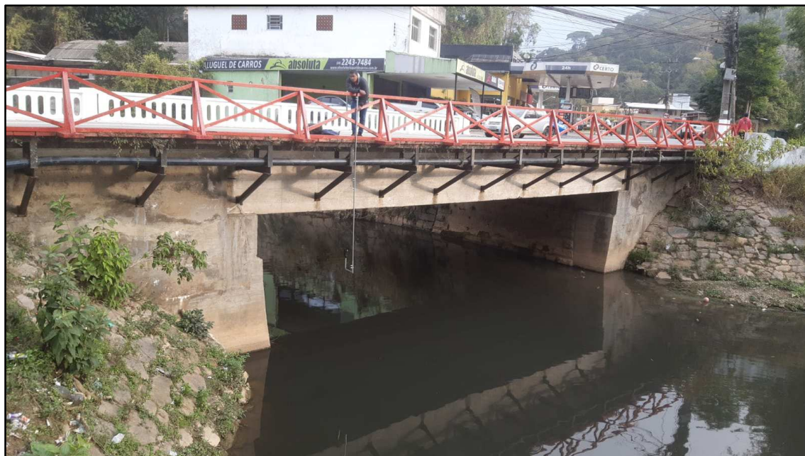
Figura 5.10 – Levantamento Topográfico com 3D Laser Scanner BLK360
