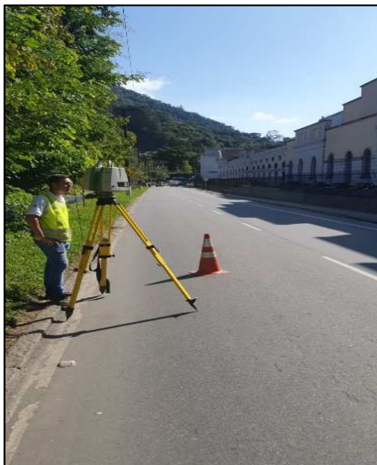
Figura 5.2 - Levantamento Topográfico com 3D Laser Scanner Leica C10
