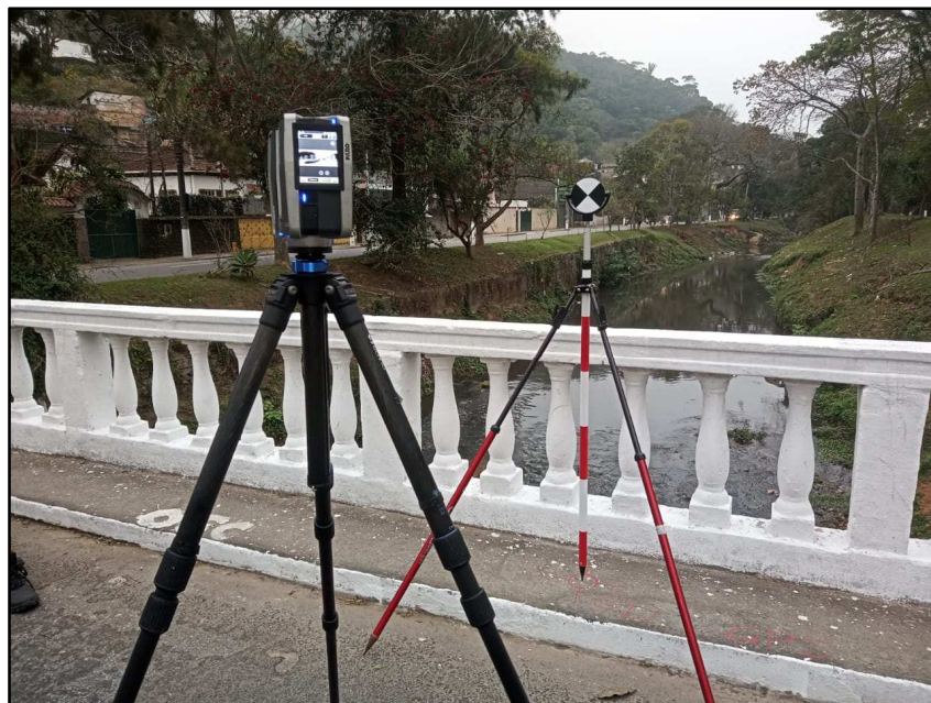
Figura 5.11 - Processo de Georreferenciamento de Nuvens de Pontos Laser Scanner
