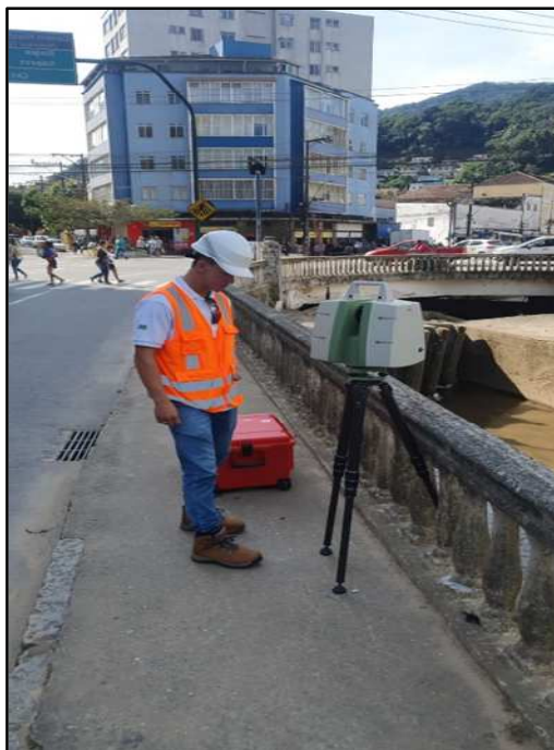
Figura 5.4 - Levantamento Topográfico com 3D Laser Scanner Leica C10
