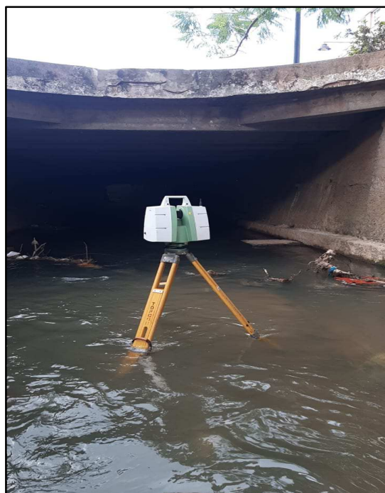
Figura 5.3 - Levantamento Topográfico com 3D Laser Scanner Leica C10
