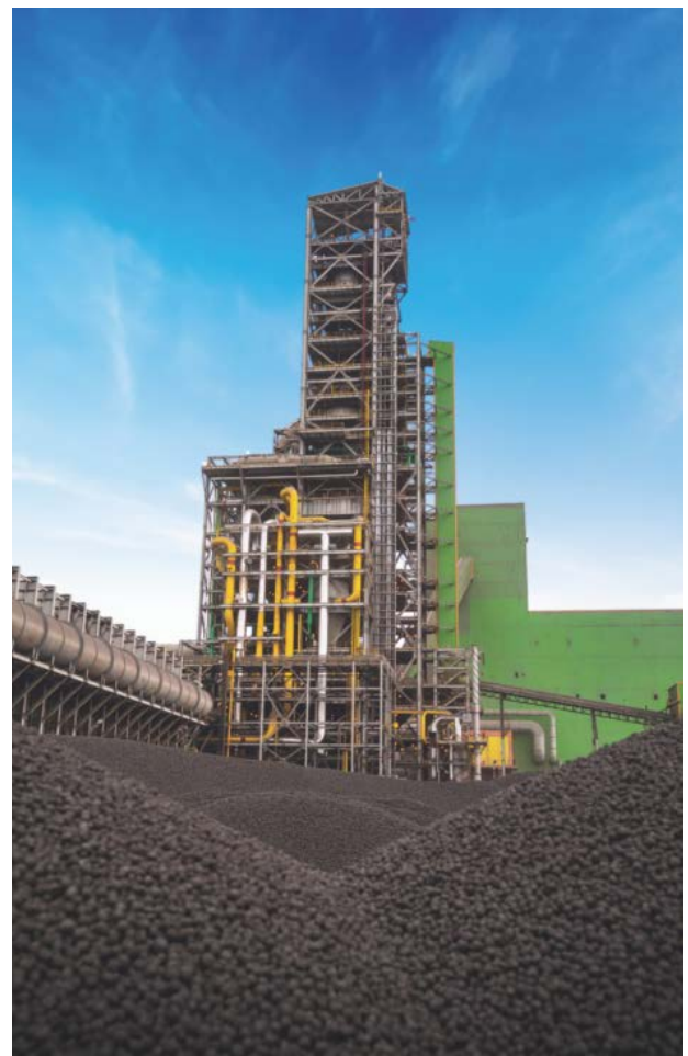
Exemplo de um forno de redução direta e pilhas de HBI após a sua produção.
