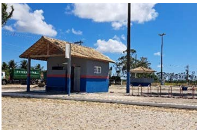
Equipamento Público em Barra do Jacaré, São João da Barra/RJ.
