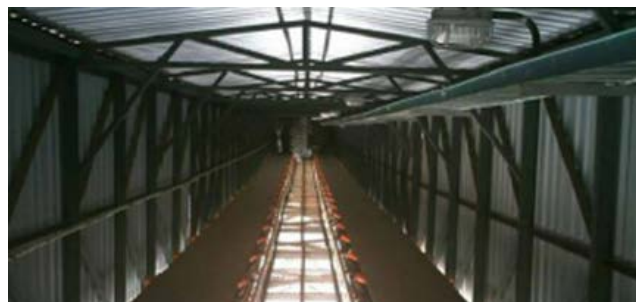
Exemplo de galeria de enclausuramento de correia transportadora.
