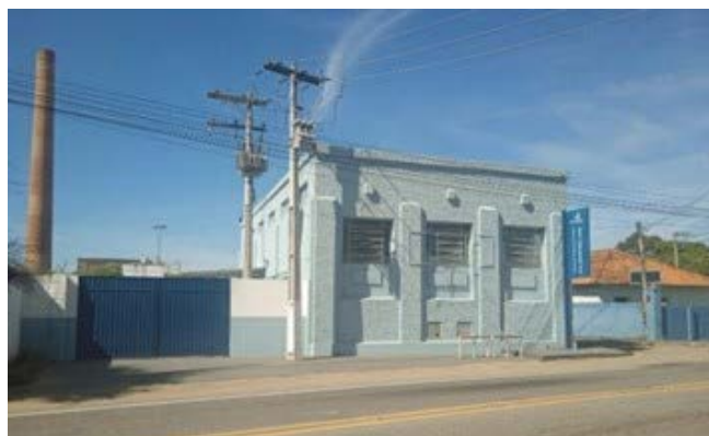
Estação de Tratamento de água em São João da Barra/RJ.
