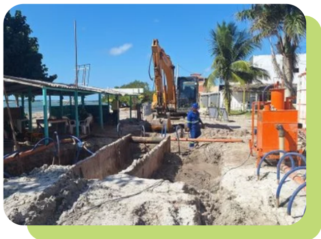
Figura 7. Obras de saneamento
