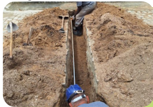
Figura 5. Obras de saneamento
