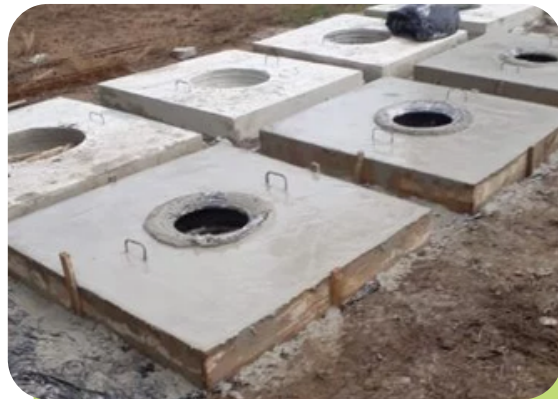
Figura 6. Obra de esgotamento sanitário, Sobara
