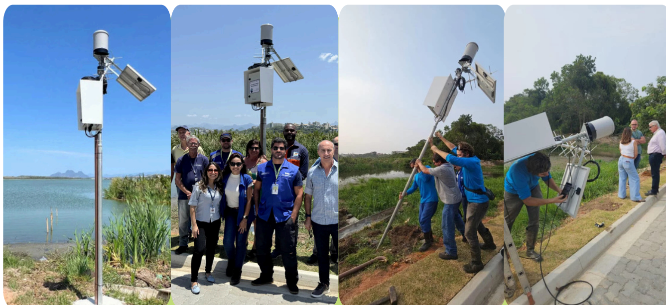
Figura 5. Instalação da Estação Telemétrica na Lagoa de Imboassica
