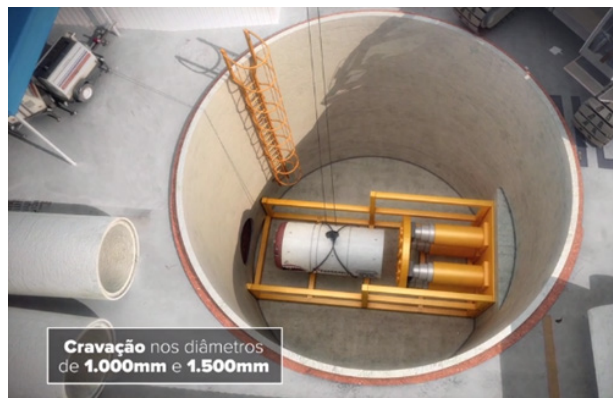
Figura 11 – Poço de Visita – Instalação de tronco coletor de esgotamento sanitário – Obra PSAM, Rua Benedito Hipólito – Centro do Rio de Janeiro
