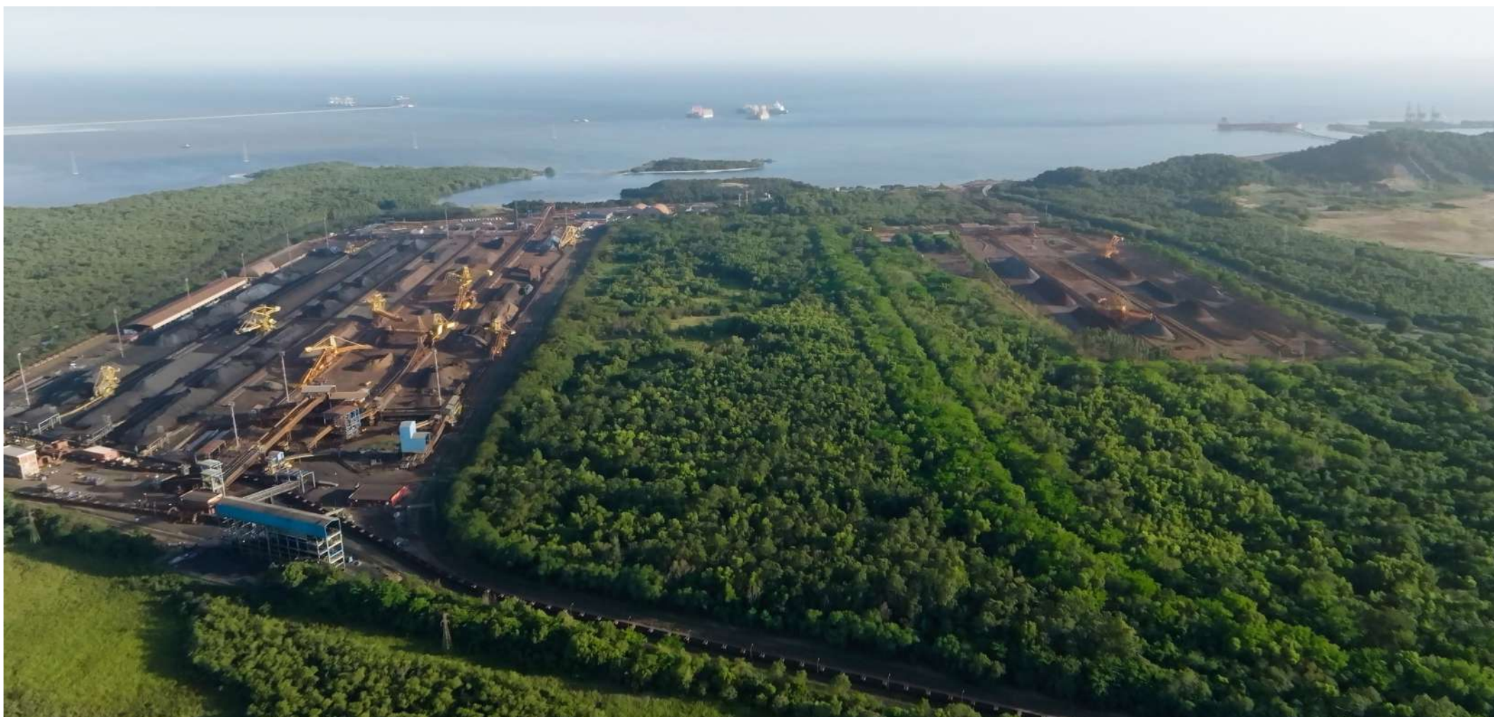
Vista geral da área prevista para a implantação do Projeto Cedro Porto do Meio, onde se observa, a esquerda, a CSN e a direita a Vale
